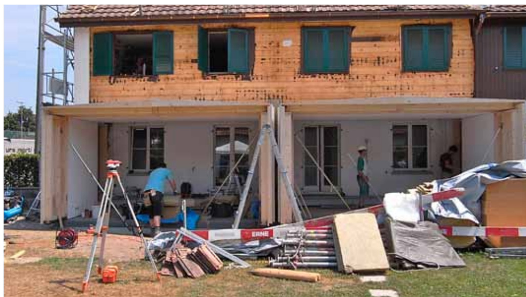
Sanierung: Gebäude während dem Umbau.
