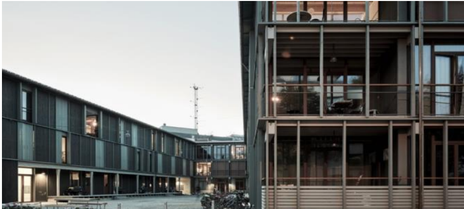
Maiengasse (Wohnüberbauung der Immobilien Basel-Stadt)
